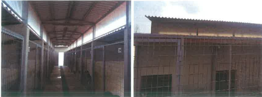
Εικόνα 1: Υφιστάμενη επιστέγαση κτιρίων φιλοξενίας
